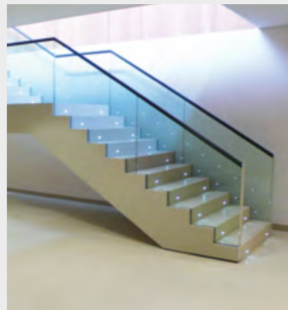
Kunstmuseum, Eingangsbereich. Frühhochfeste Klebe- und Fugenmörtel unter großformatigen Betonwerksteinbelägen.
