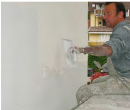
Mineralischer Edelputz auf Basis von Dyckerhoff Weiss DECOR läßt sich gut verarbeiten und bringt Farben brillant zur Geltung.
