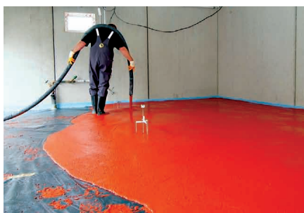
Gießen des Estrichs
