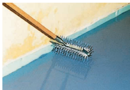
Entlüften mit der Stachelwalze
